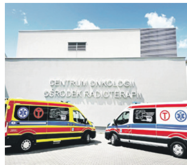
Centrum Onkologii w Tarnobrzegu, Zakład Radioterapii, wejście od strony parkingu szpitala
