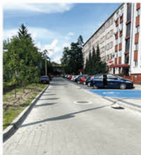
Przebudowa drogi wewnętrznej od ul. Wyspiańskiego do ul. Tracza.
